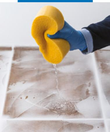
Lavaggio con acqua tiepida per la successiva rimozione di Planiprep Remove 4 LVT
