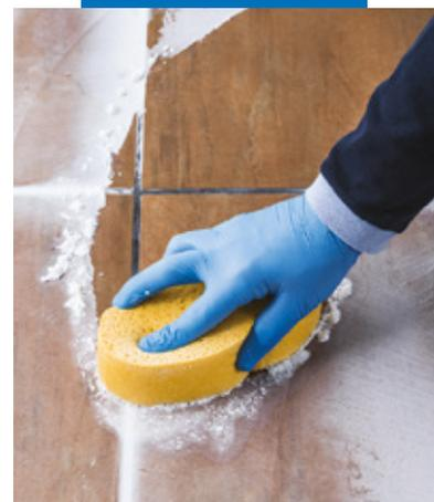
**Rimozione di Planiprep Remove 4 LVT con spugna**
